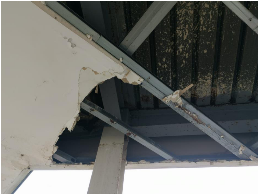
Foto ammaloramento controsoffittature intradosso portico per infiltrazioni
